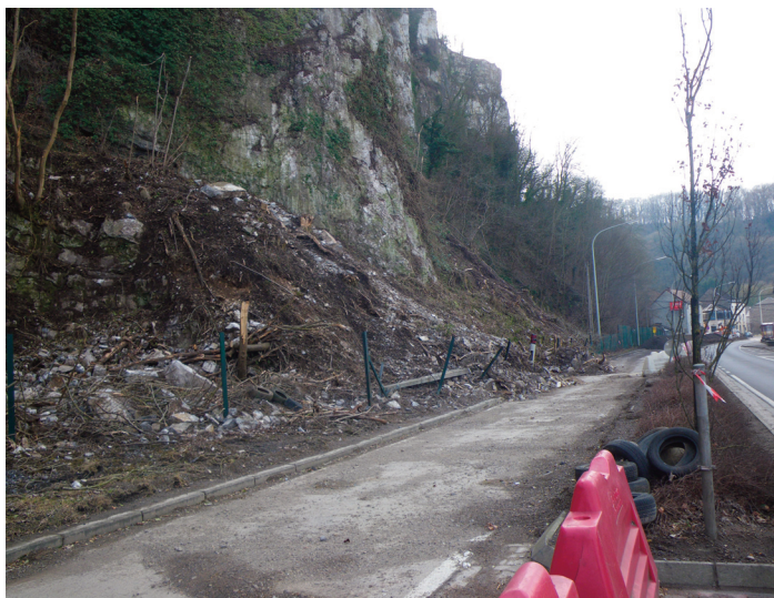
Fig. 4. Exemples d'éboulements affectant la vallée de la Meuse: 4.a./ paroi rocheuses peignée et grillage de protection placé pour éviter la chute de blocs sur la route nationale du fond de la Vallée à Thon Samson. 4.b/ Anhée blocs ayant baré la route à 4 bandes (Photo V. Vautron RTBF).
