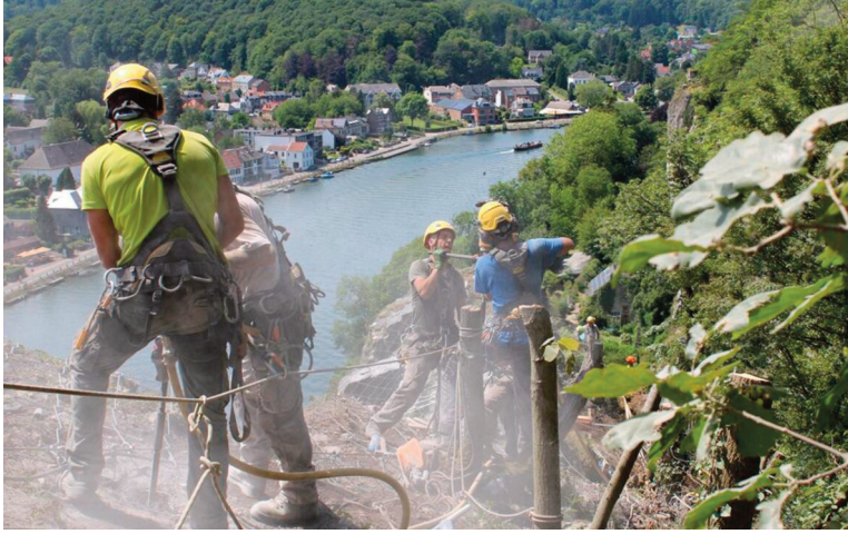
Fig. 14. Rochers de Fresnes - travaux de consolidation en 2019, à la suite de l'éboulement de 2018
