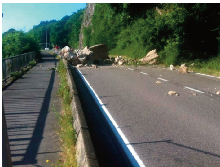
Fig. 4. Exemples d'éboulements affectant la vallée de la Meuse: 4.a./ paroi rocheuses peignée et grillage de protection placé pour éviter la chute de blocs sur la route nationale du fond de la Vallée à Thon Samson. 4.b/ Anhée blocs ayant baré la route à 4 bandes (Photo V. Vautron RTBF).
