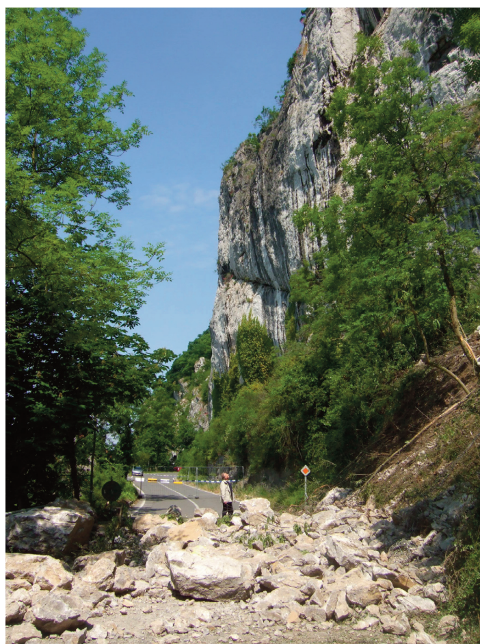
Fig.10. Frênes: éboulement de 2008 ayant bloqué la route en bordure de la Meuse pendant des semaines (Photo CWEPPSS)
