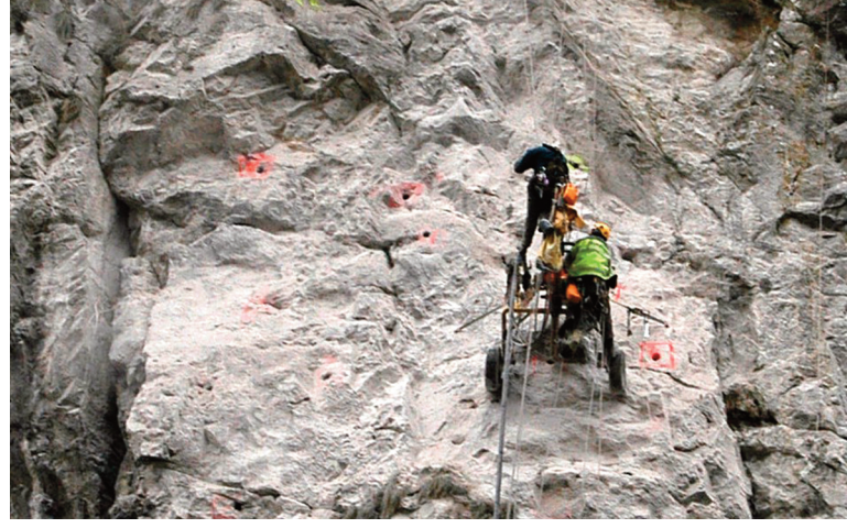
Fig. 15 Travaux en pleine paroi (placement de broches - photos L. Funcken)
