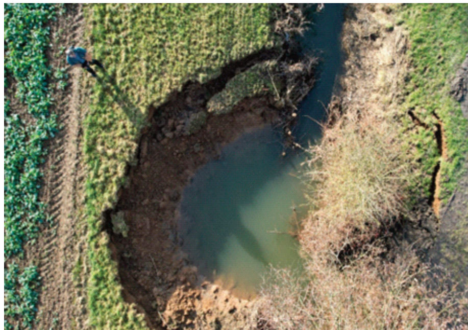
Fig. 1. L'effondrement de la Dendrelette au 29/01/2024 / - relevé par drone - JB Schram
