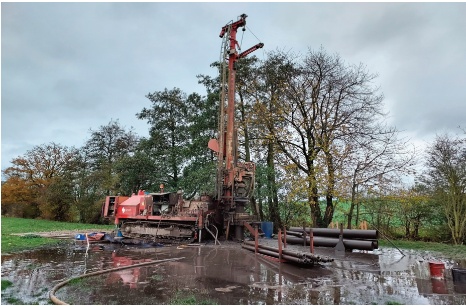
Fig. 3. Forage du piézomètre entamé en nov. 2023. Le ruisseau (représenté par la ligne d'arbres) n'est qu'à quelques mètres – Photo SWDE.
