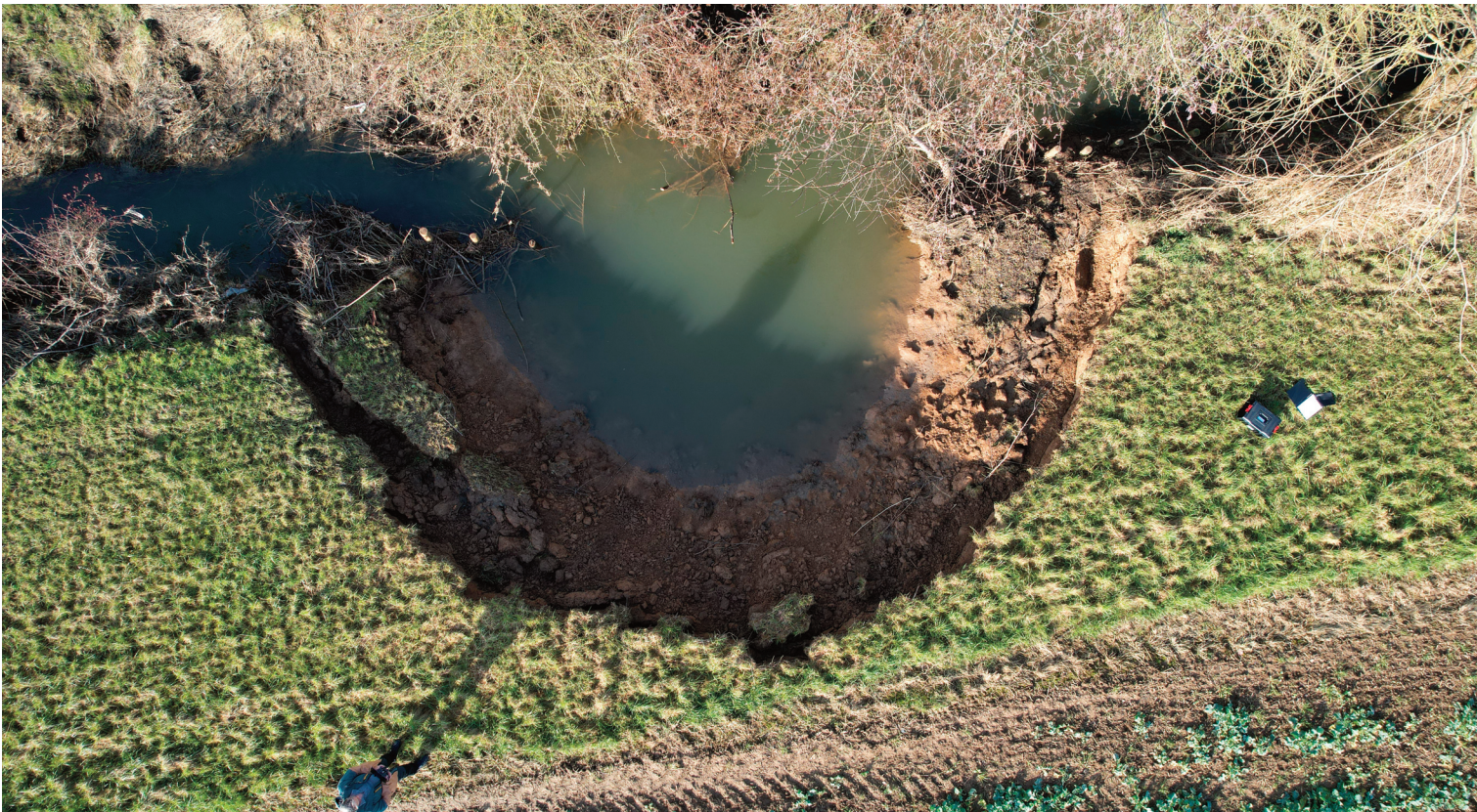
Fig. 8. En février 2024, l'effondrement avait une forme asymétrique, les berges de la rive droite étaient encore en place mais instables (photo JB Schram, 29/01/2024).
