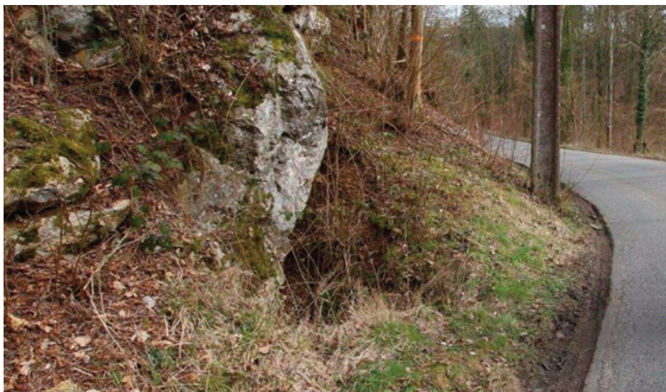
Fig 6. Le Trou du Tournant pourrait être assez facilement aménagé afin d'absorber une bonne partie des eaux de ruissellement de la route, qui autrement s'écoulerait jusqu'à Bouvignes.
