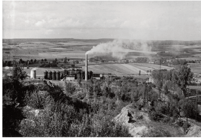
Fig. 6. L'usine de Musson en bordure de la voie de chemin de fer, avec à l'avant plan les descenderies pour transporter le minerai jusqu'au haut fourneau (source archives Musées 4M).
