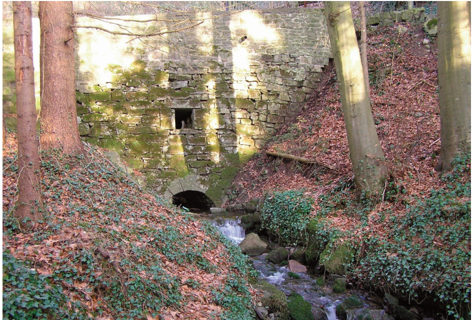
Photo 4: le site de la résurgence de Ny avant sa démolition en septembre 2012. On y voit bien le conduit vouté de sortie de l'eau tel que dessiné par Guy de Block ainsi qu'une lucarne dont on ne saura jamais sur quoi elle donnait (ph. R. Cordier).
