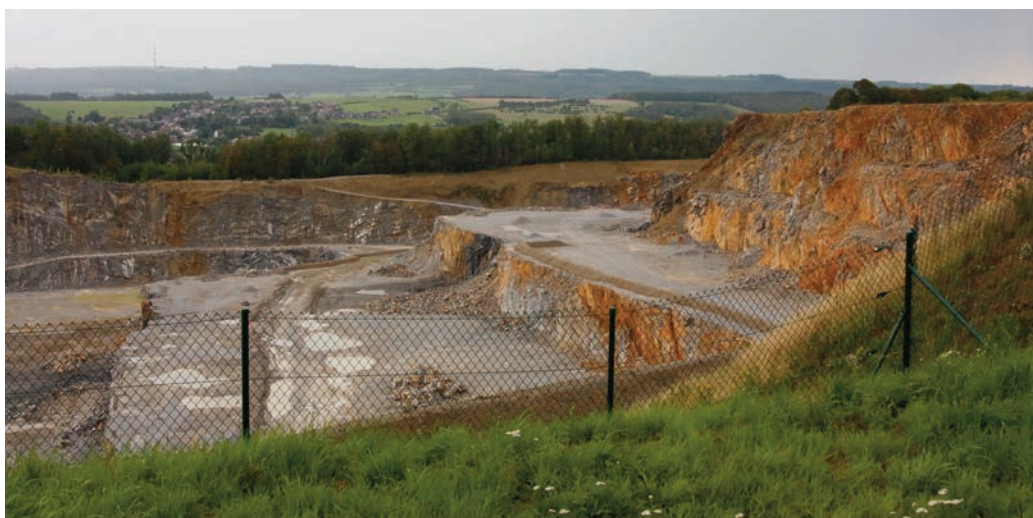
Fig. 3. Panorama vers la Famenne à l'ouest, laissant voir les 5 paliers d'extraction de la Boverie et le pendage redressé quasi à la verticale sur la paroi du fond
