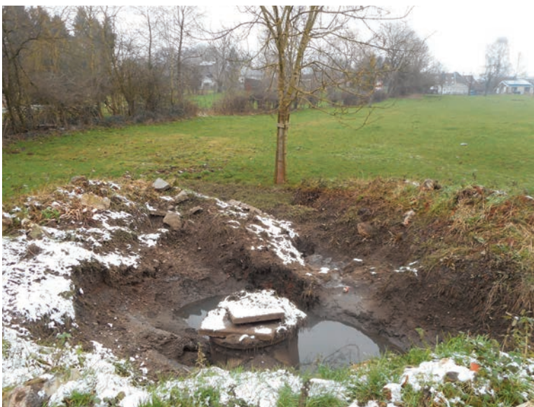
Photo 6. Dans le vallon sec de la Turlurette, l'agolina aménagé (42/7-148) a vu son environnement chamboulé suite à une crue en 2014 : gros affouillements par les eaux remontant sous la structure saturée.
