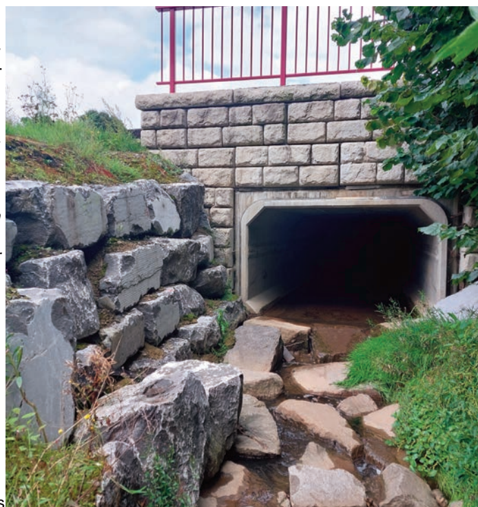
Photo. 4. Le nouveau pont, enjambant le Bief, construit en 2021. Les bas côtés consolidés en mode semi naturel pour résister aux coups de crues.
