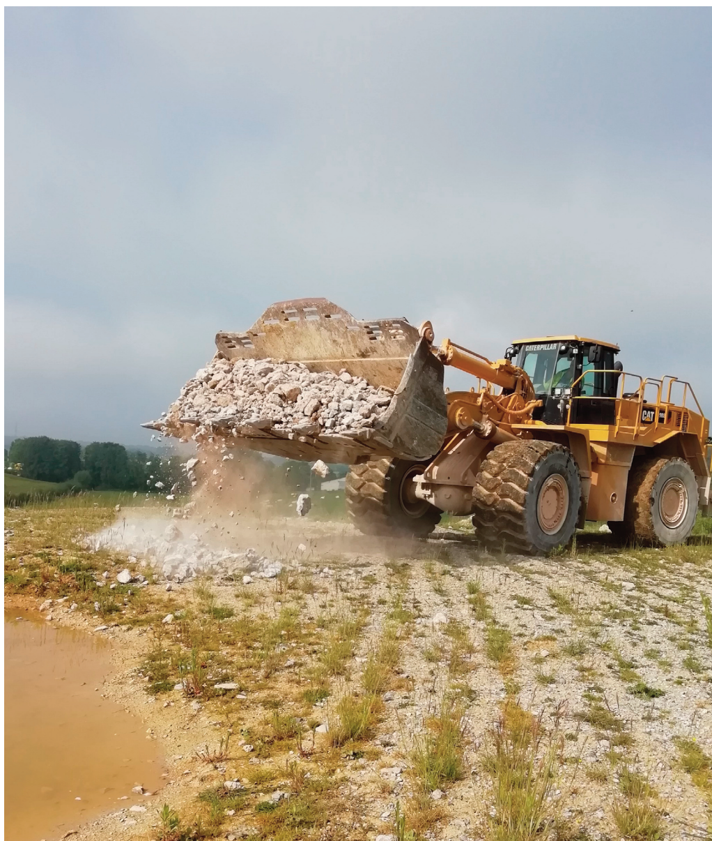
Fig. 7. Création d'abris et de refuges pour la biodiversité à l'aide de blocs et de débris de carrières déplacés par un bull, en bordure d'une mare (photo Vanschepdael M.)
