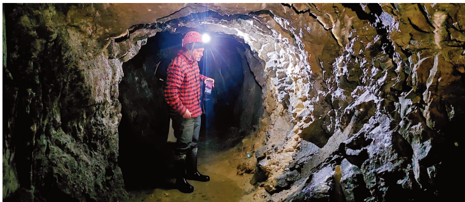
Fig07. Passé les 10 premiers m depuis l'entrée, qui sont appareillés en moellons et briques, la galerie est directement creusée dans les grès de teinte jaune à ocre
