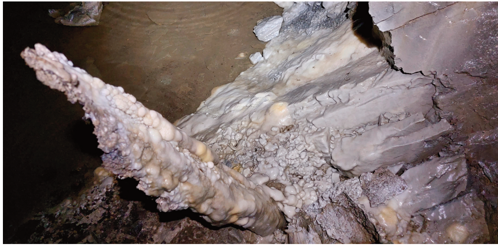
Fig10. L'ancienne boiserie de soutènement est comme pétrifiée et recouverte par plusieurs mm de calcite provenant de l'eau de percolation tombant depuis la voute (photo FP)
