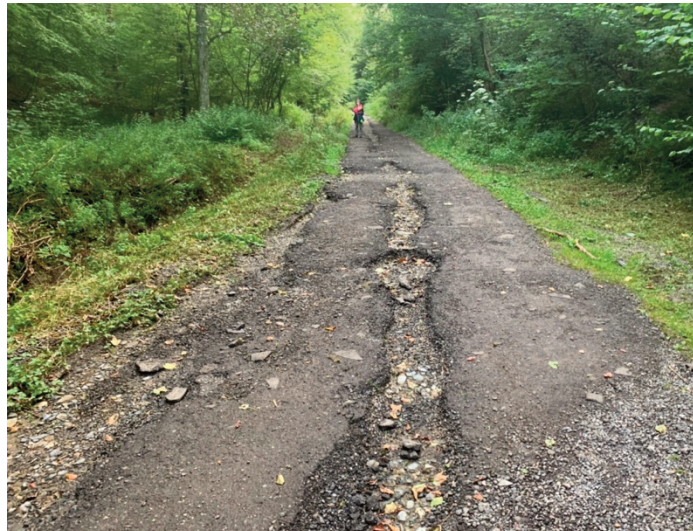
Photo 2. Le chemin forestier qui longe le lit aérien et sec en permanence du ruisseau de la Ferrée est emprunté par de nombreux promeneurs et joggeurs. Il n'était pas en excellent état, et s'est encore considérablement raviné suite à la crue.
