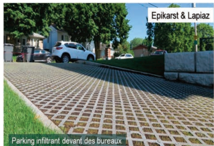
Fig. 7. Les travaux réalisés pour lutter contre les inondations en milieu urbain s'inspirent de la nature... en particulier du karst, avec des équipements qui "copient" les capacités d'infiltration et de stockage des aquifères calcaires !
