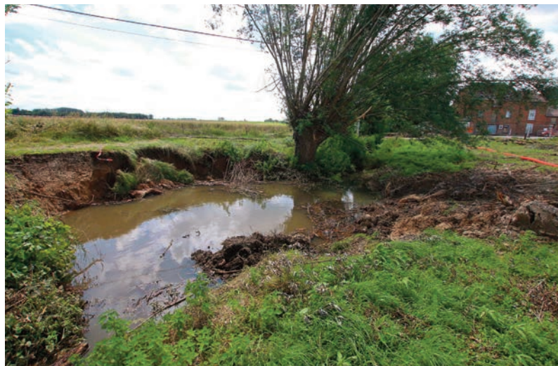
Fig. 2. Effondrement du Cerisier. Le versant sud-est, subvertical, domine l'eau de 1,30 m (photo 07/07/2021).
