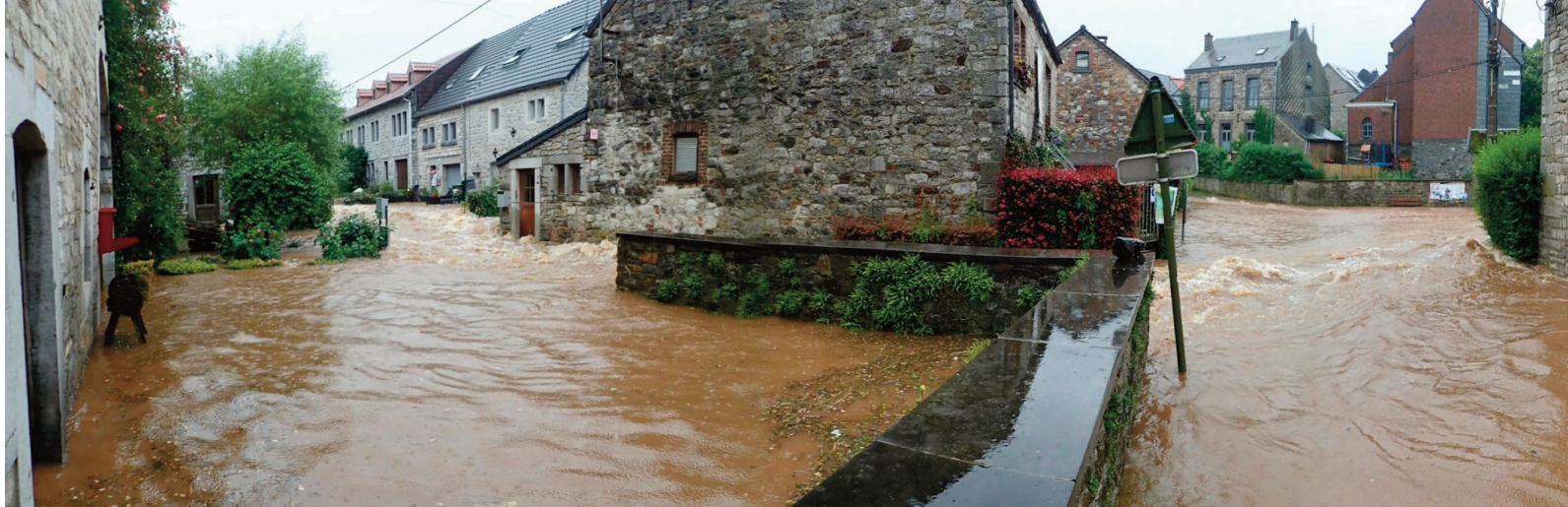
Photo 3. Le centre du village de Deigné a été à la fois frappé par les eaux des chantoirs d'Adzeux et du Rouge Thiers qui débordaient vers l'aval (partie gauche de la photo) et le torrent provenant de Cheffosse (à droite). Les flux convergents ont transformé les rues en véritable rivière.
