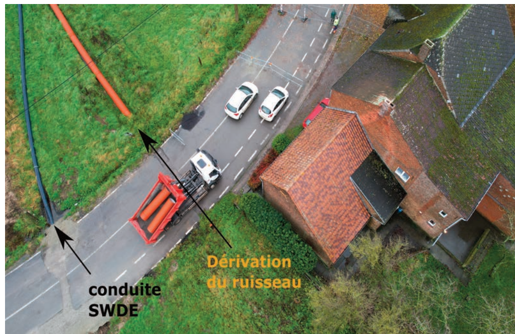
Fig. 7. Afin d'enrayer le processus de soutirage, le ruisseau des Prés de Rabisse (canalisation orange) et l'adduction d'eau de la SWDE (socorex noir de grand diamètre) ont été déviés au sud-ouest de la ferme. Ces réparations sont temporaires ; tout le réaménagement de la chaussée et la gestion des eaux devront être repensés à l'avenir, avec de nombreux intervenants à coordonner (vue par drone, 02/12/2021 - J.-B. Schram).
