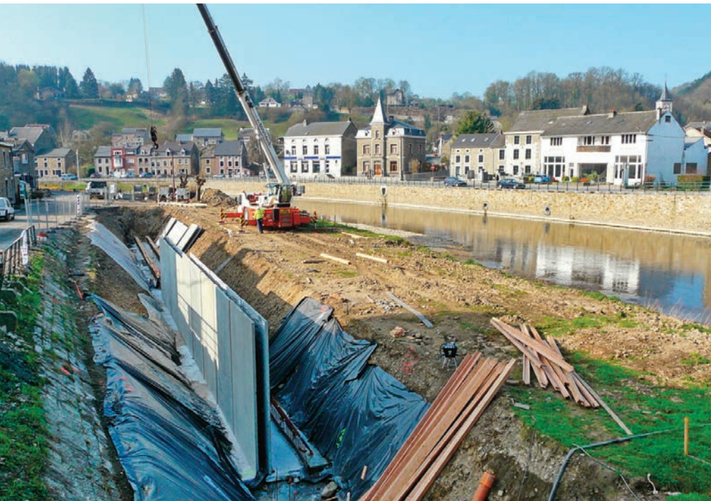
Fig. 2. Construction d'un mur anti-crue le long de l'Ourthe à Comblain-au-Pont suite aux inondations de janvier 2011. Cet équipement a été totalement submergé lors des inondations de juillet 2021 (photo Contrat de Rivière Ourthe).
