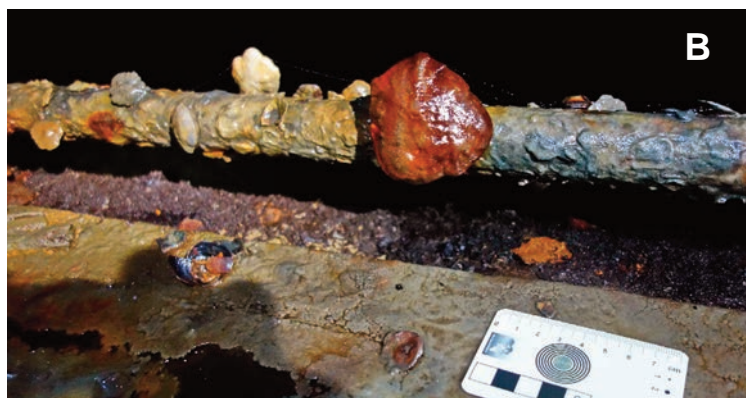
Fig. 3. IRSS se développant sur la barrière longeant le chemin de halage du tunnel de Godarville. (A) IRSS de plus de 2 cm de large dont les deux « coques » sont ouvertes. La flèche blanche pointe la coque supérieure, la flèche bleue la coque inférieure. (B) Plusieurs IRSS de différents diamètres, « coques » fermées.
