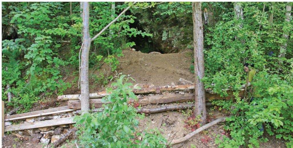
Fig. 4. En contrebas du porche, système de retenue des blocs pour éviter qu'ils ne chutent sur le RAVeL (photo juin 2021).
