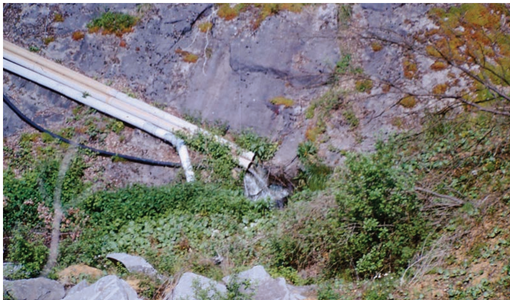
Fig. 4. Les différents tuyaux déversant les eaux usées dans la fissure karstique de la carrière d'Anthisnes. Photo CWEPSS 1987, avant que cette partie de l'exploitation ne soit remblayée.
