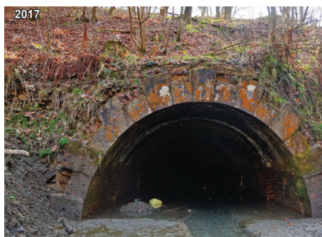
Les remblaiements / déblaiements de l'entrée modifient la hauteur émergée dans le tunnel.
