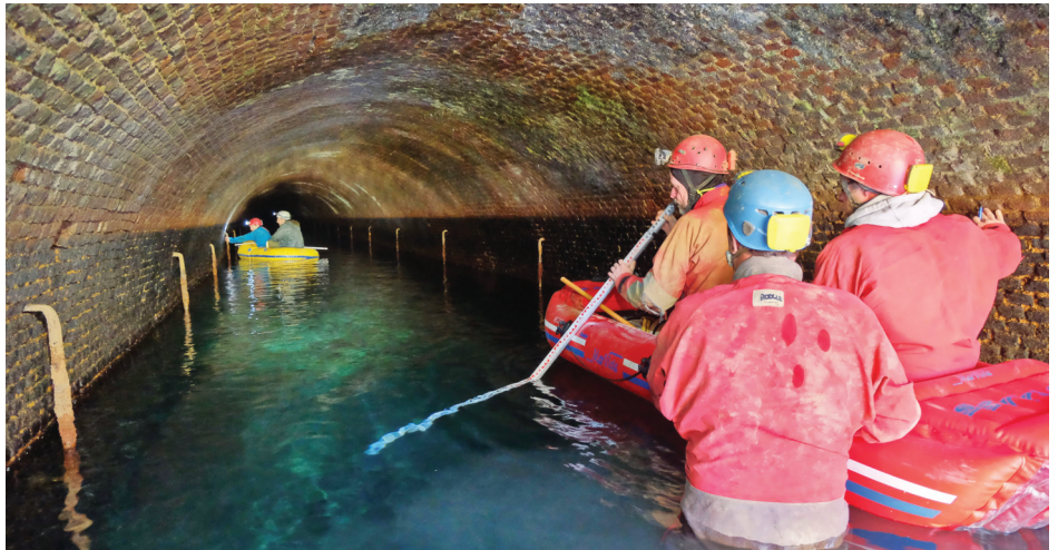
Mise à l'eau des canots pour les visées topographiques. "Ligne de crue" bien visible (photo VG)
