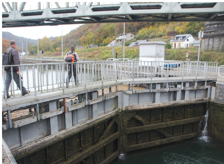
l'écluse à Anseremme à proximité de la confluence avec la Lesse.
