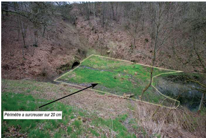
Périmètre à creuser pour limiter l'accès à l'entrée de la galerie tout en redonnant au site son aspect historique.
