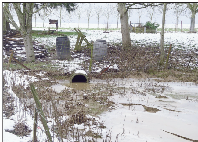
Une des canalisations (Tub1) amenant l'eau depuis la chaussée romaine vers le vallon sec et les pertes de Herlem.
