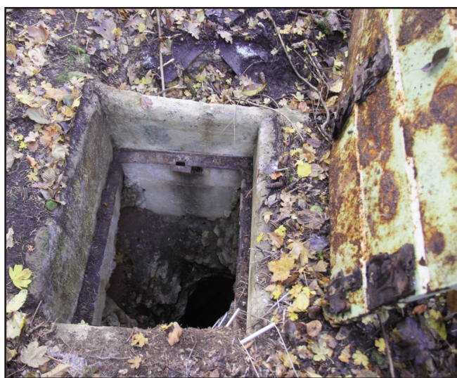
Entrée principale de la cavité ouverte à même le sol et protégée par une taque.
