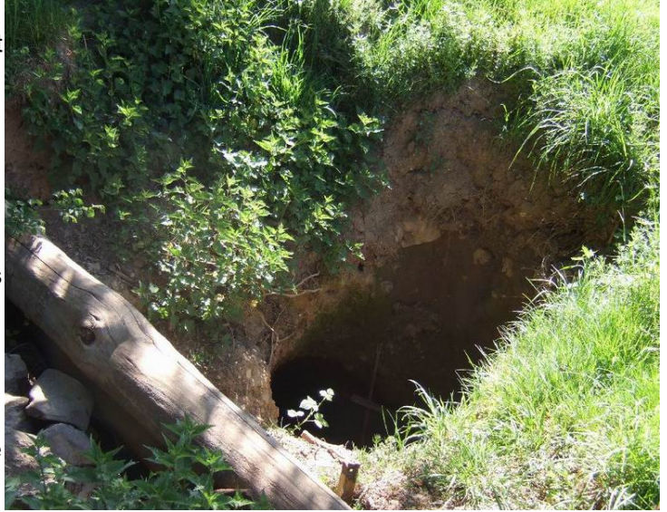
Effondrement de la la Fabrique d'Eglise , faisant l'objet d'une désobstruction pour tenter d'y découvrir des prolongements souterrains intéressants.
