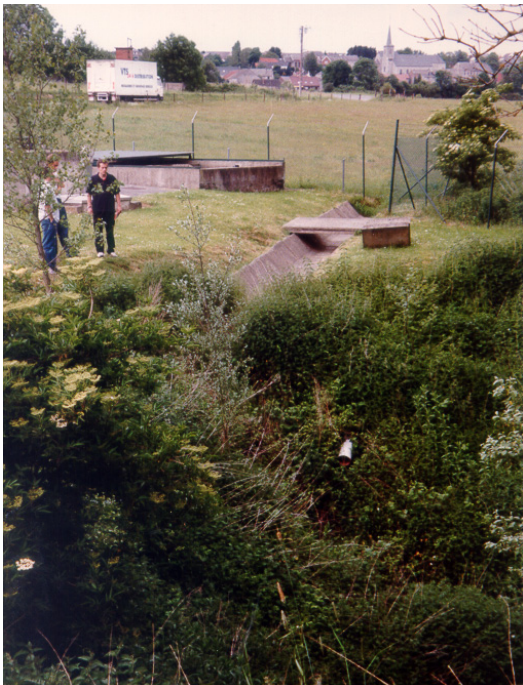
Dépression absorbante de Frumont située juste en aval de la station d'épuration
