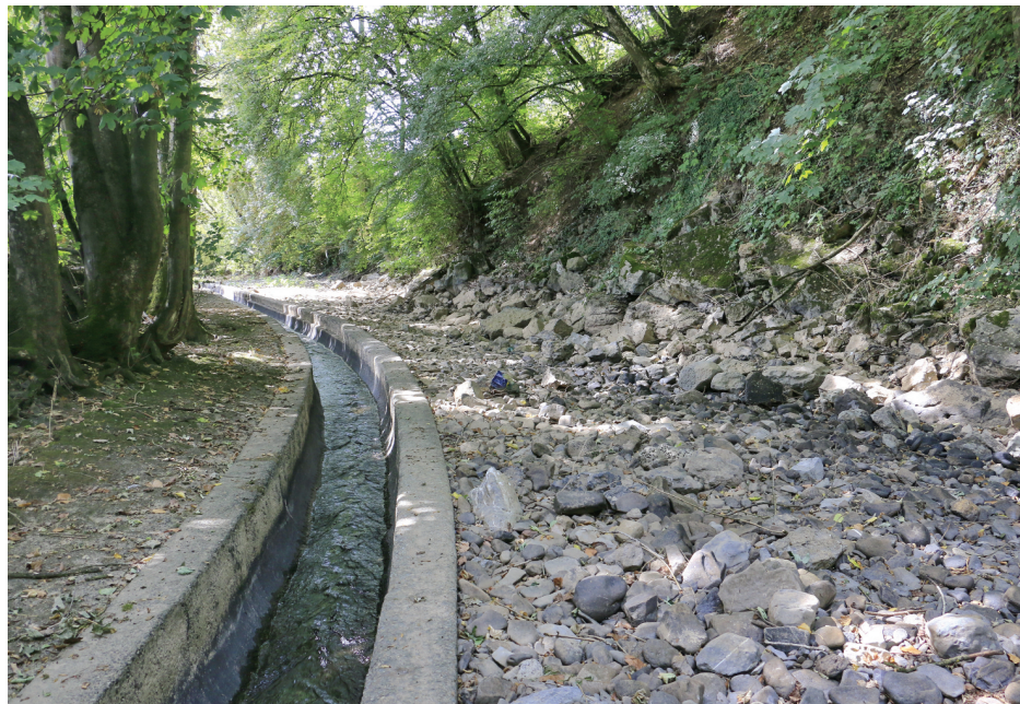
Fig. 4. Canalisation en béton dans le lit de la Wamme, afin qu'un débit minimum d'eau échappe aux pertes (à droite de la photo) et pour maintenir un écoulement en surface à l'aval de Kerwée.
