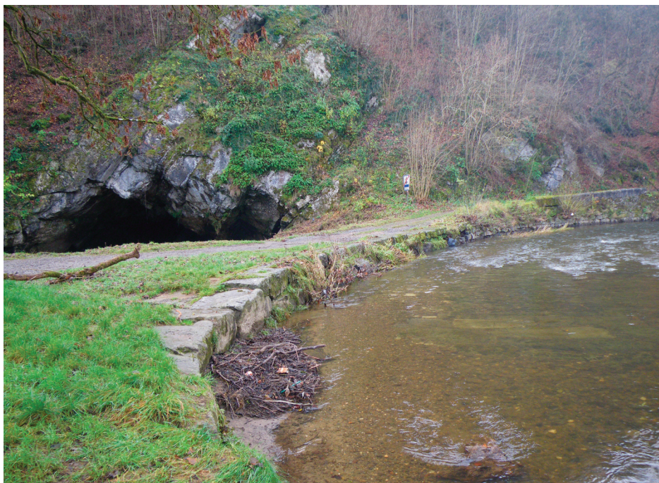
Fig. 2. Digue et dallage de la Lomme à hauteur du Nou Maulin pour tenter d'enrayer une perte totale de la rivière en amont de Rochefort, à l'image de la Lesse à Belvaux (photo 2014).
