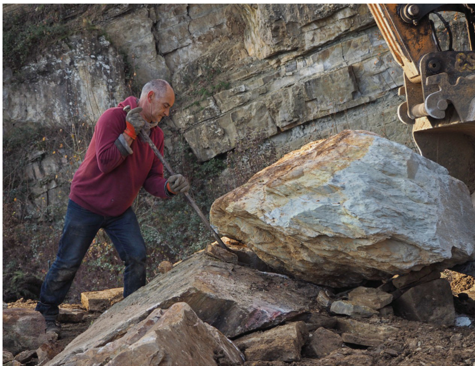
Paolo Gasparotto installe un énorme bloc de quartzite cambrien à la base du mur géologique.
