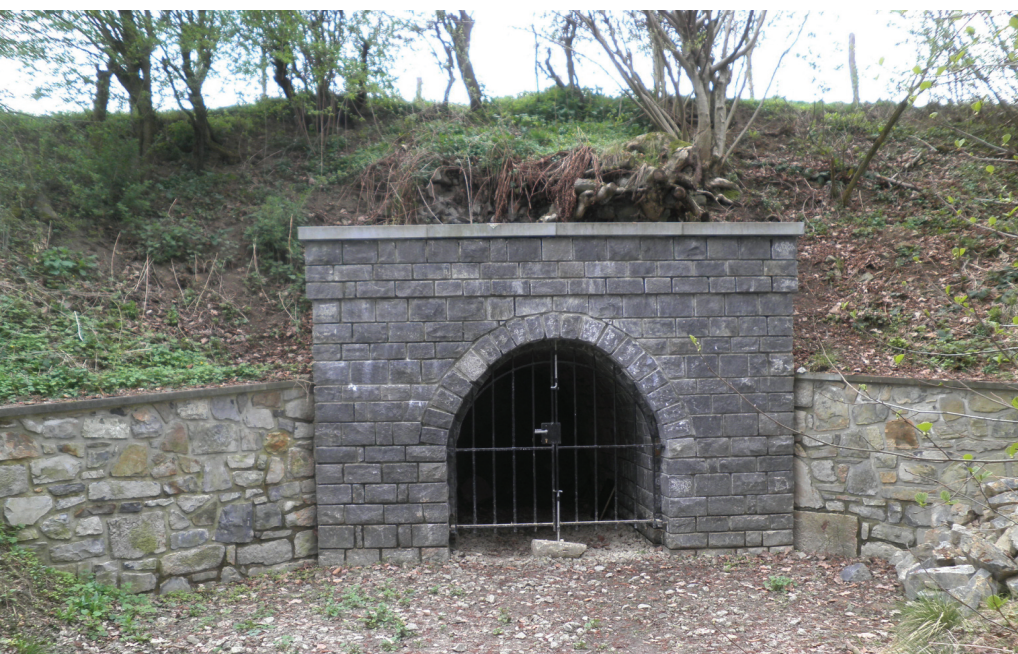
Fig.06. Oeil de la galerie d'exhaure de la mine Lindengraben-Fossey, le Luisenstollen (la galerie Louise).
