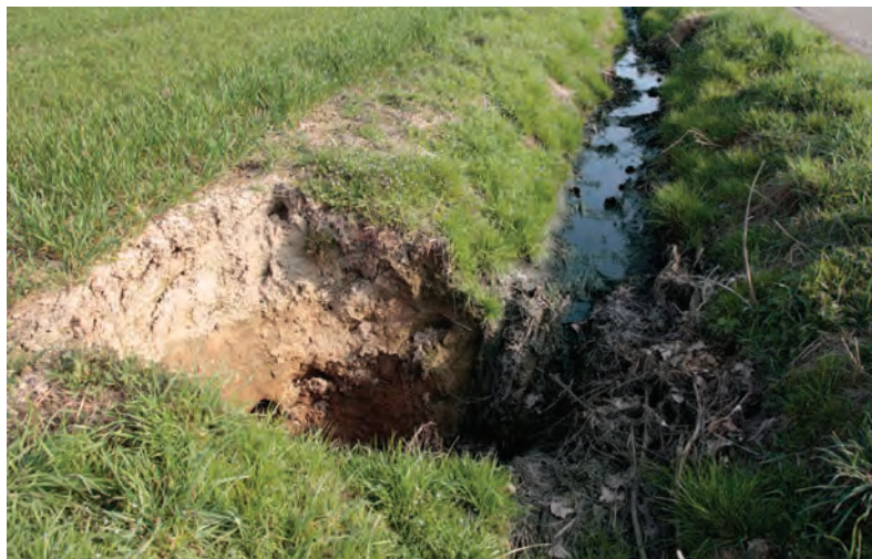
Fig. 2. Rejets d'eaux usées directement dans le karst et les eaux souterraines à Marchin (mars 2014). Risque de contamination pour les eaux souterraines en "polluants classiques" mais aussi en substances émergentes présentes dans les eaux d'égout.
