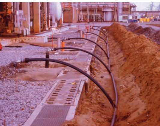
Fig. 2 – Installation d'un système de traitement par bioremédiation in-situ sur un site industriel.
