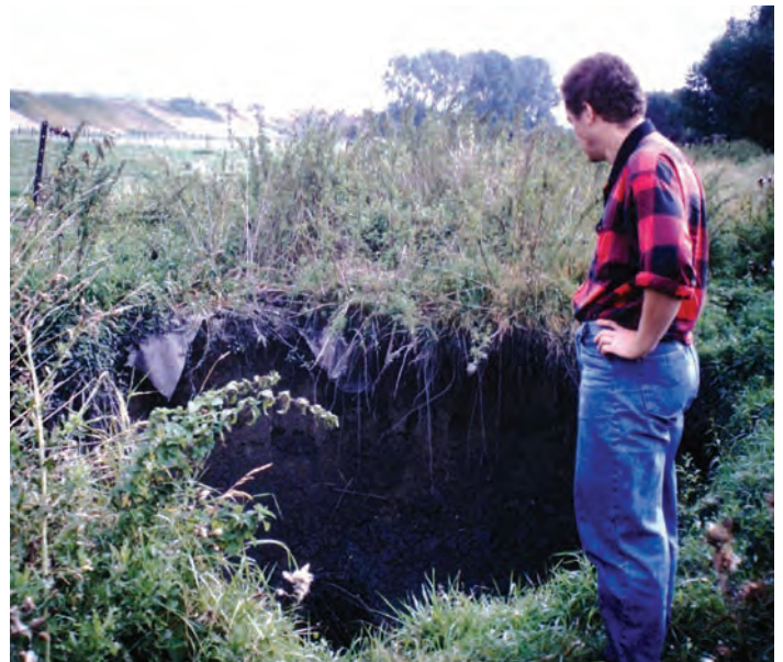
Puits naturel du Rieu de Warchin à Gaurain, ouvert brutalement en mai 1996, présentant une forme de fontis et une profondeur de 5m. Cet affaissement est directement lié au dénoyage local, notamment causé par l'exhaure des carrières voisines (photo G. Thys).
