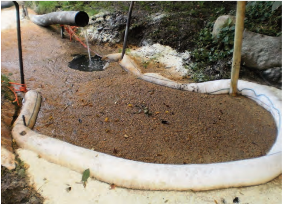
Fig. 4; Fin 2014, une pollution aux hydrocarbures avait affecté le bief (via les égouts). La police de l'environnement avait dû sécuriser le site (barrage flottant) et rechercher l'origine de ce polluant.
