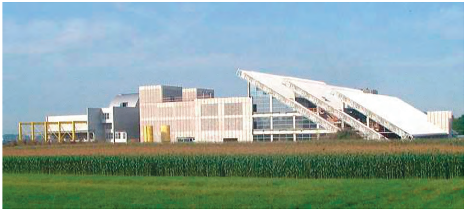
Station de traitement de la Transhennuyère à Gaurain-Ramecroix.
