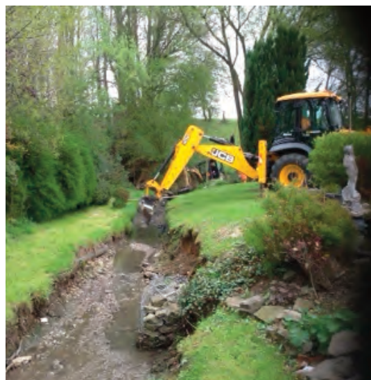
Fig. 3. Périodiquement, la commune vient curer le ruisseau en amont du chantoir. Ces travaux lourds qui engendrent des dégâts à la propriété, n'ont un effet que très temporaire.
