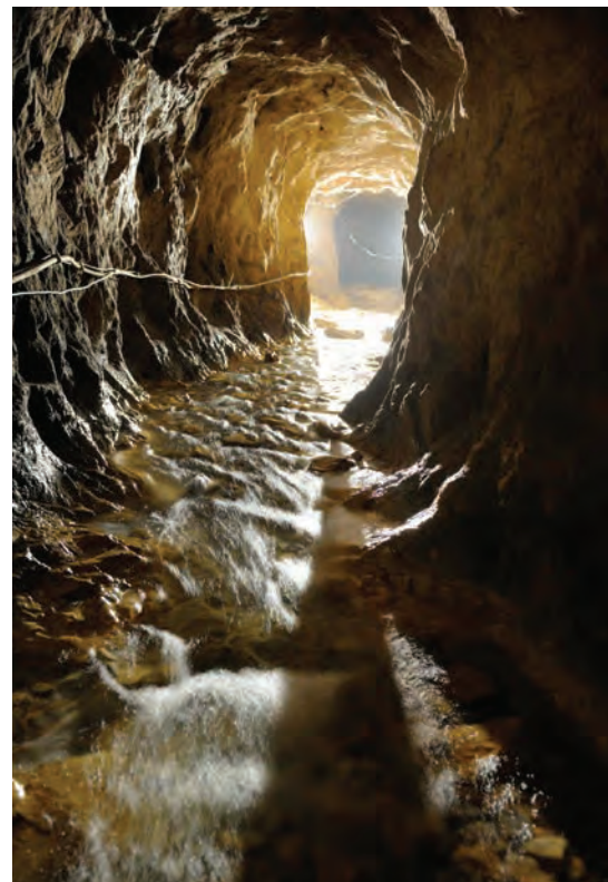
Captage de la Source Tridaine (Rochefort), équipée pour suivre les fluctuations de hauteur d'eau et les restitutions de traceurs injectés lors des études pour la délimitation des zones de surveillance (photo G. Focant).
