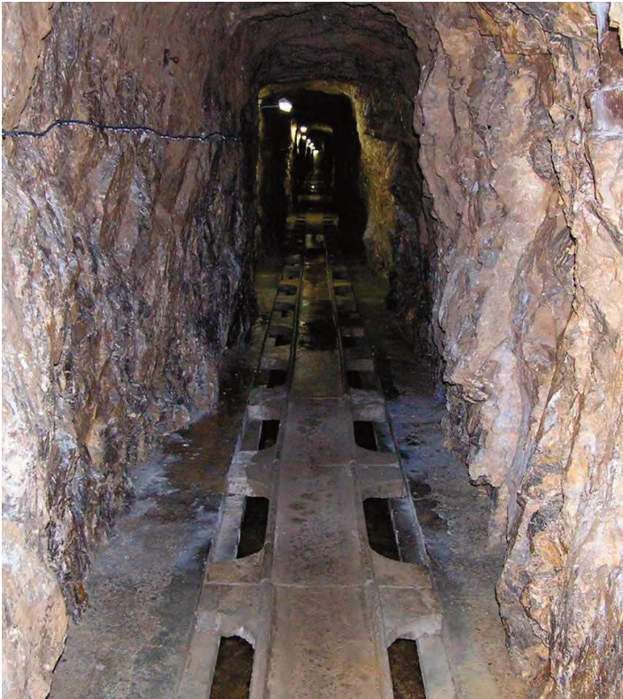
Photo 2. Les galeries captantes du Néblon (CILE) d'une longueur de 600m drainent des sources alimentées par l'aquifère des calcaires du Carbonifère. Il s'agit de la ressource d'eau potable principale pour la ville de Liège.
