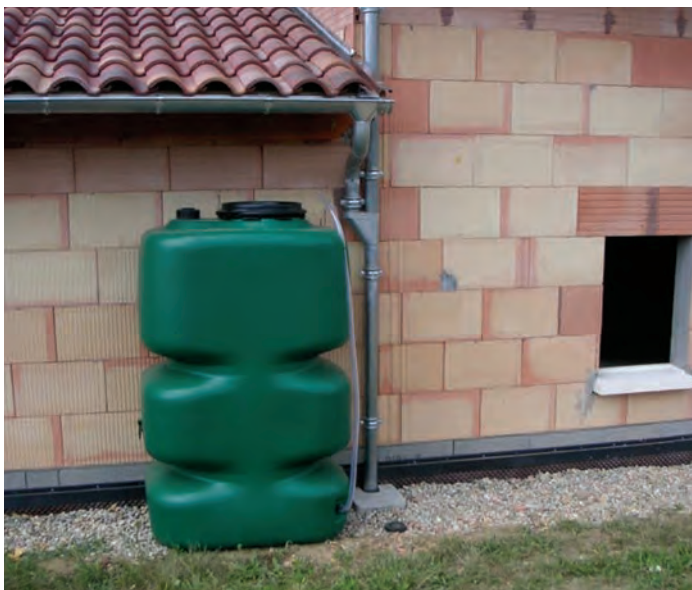
La généralisation des citernes à eau de pluie pose le problème de la répartition des coûts de l'épuration, calculé sur la consommation d'eau.
