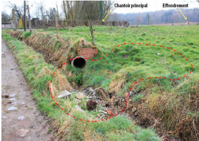
Dépression aval en partie remblayée, elle aussi située sur une venue d'eau qui a provoqué son approfondissement.
