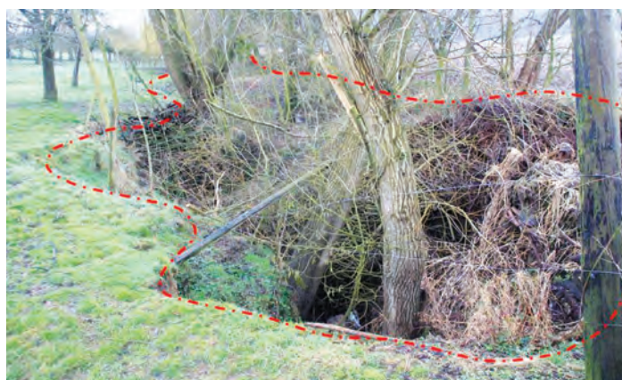
Le chantoir tend à s'étendre (élargissement) et est continuellement remblayé par le fermier. La roche en place n'a pas pu être observée dans son fond.
