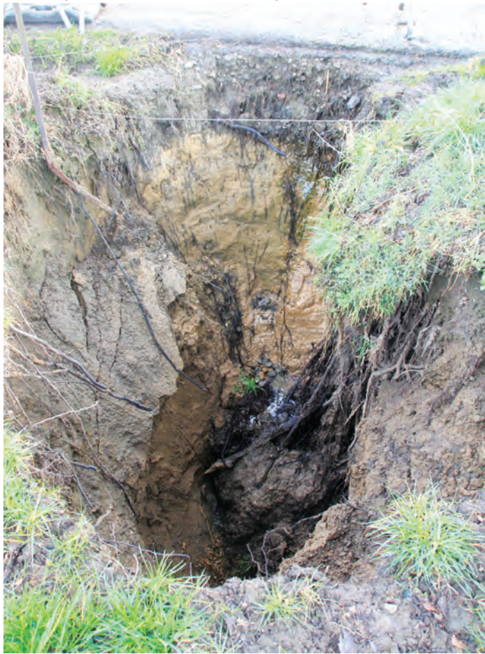
L'eau du caniveau qui cascade dans le trou de 3m de profondeur permet au soutirage de se poursuivre.
