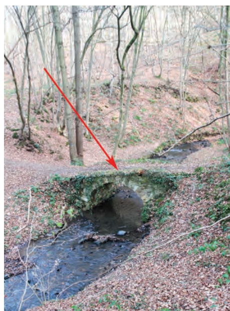
Le pont médiéval franchissant la Solières à la limite amont entre les calcaires et les grès fut un des points pour caler notre cheminement et calculer les coordonnées relatives
