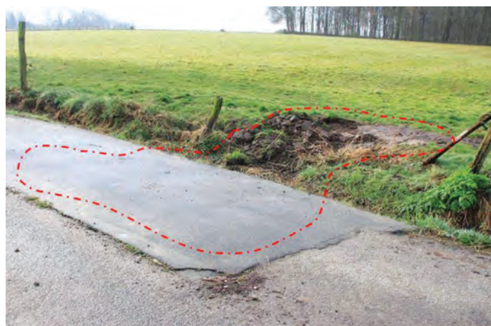
Réparation récente de la route (mars 2015), avec report (témoignage du fermier) de l'étendue du trou.
