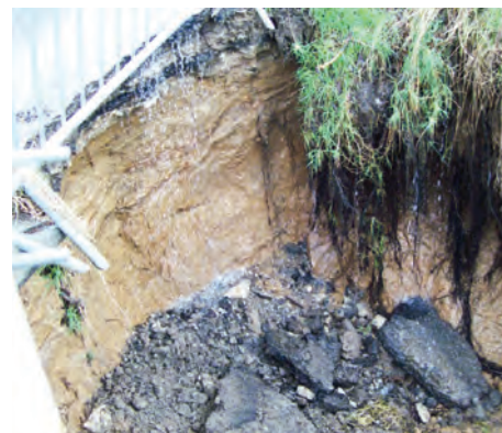
Le puits naturel (39/6-13) s'est élargi et a emporté une partie de la route en février 2016 suite aux pluies importantes (photos V. Gourdin)
