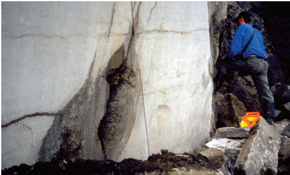
Fig. 5. Un fantôme de roche dans la carrière du Clypot (Soignies). On voit qu'une forme en galerie se dessine dans le front. La matière résiduelle laisse apparaître une surface granuleuse : ce sont des entroques résiduelles. Lorsqu'un courant d'eau traverse cette altérite par la porosité qui la rend perméable, elle peut mécaniquement éroder cette altérite ameublie.
