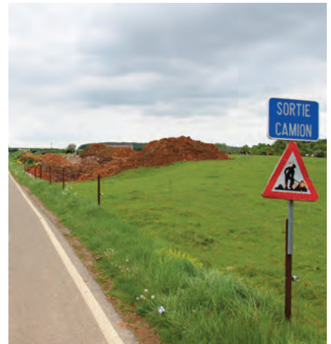
Les dépressions le long des routes et à proximité de chantiers seront les premières à accueillir des terres excavées (photo CWEPS, mai 2014).
