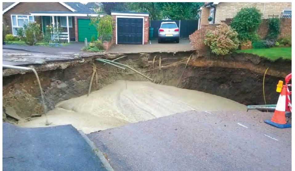
50 camions ont été nécessaires pour remplir de béton l'énorme vide.
