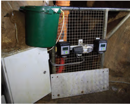
Station de détection de gaz « Dräger » (mesure en continu du CO, CO2 et O2) au sommet du Puits Bernard dans le réseau touristique.
