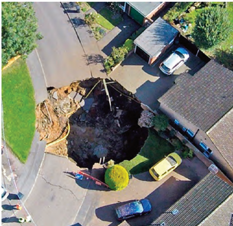
Vue aérienne de l'effondrement ayant emporté la rue et menaçant très directement les maisons d'un quartier résidentiel.
