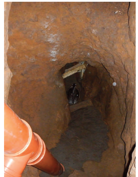
Obstruction du Puits Bernard avec couvercle "sous pression" permettant d'encore accéder au réseau inférieur (photo J.-C. Garigliany).
