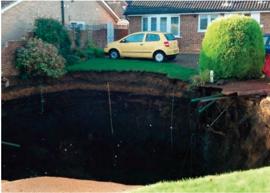
L'effondrement soudain présente des parois verticales et il a sectionné les canalisations d'eau et de gaz.
