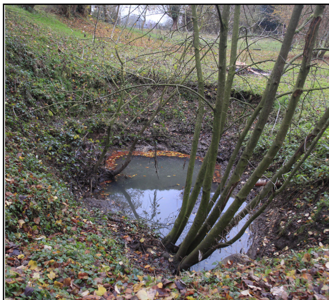
Vers l'aval de l'agolina, le propriétaire a placé un drain pour évacuer le trop-plein d'eau vers cette dépression absorbante. Celle-ci tend également à se colmater, du fait des déchets amenés par les eaux.
