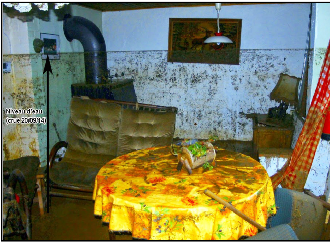
Intérieur de la maison de Rudi Dhoore, où l'eau est montée à 1,70m.
