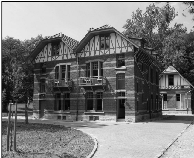
Ancien captage transformé en « Espace de l'Homme de Spy » (Photo EHoS/HB).
