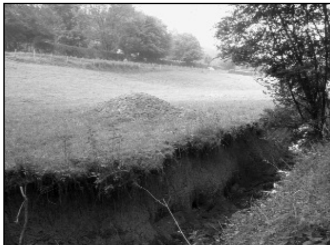
De part et d'autre du ruisseau les affaissements qui se forment sont systématiquement remblayés par l'agriculteur - autour du Pt 7.
