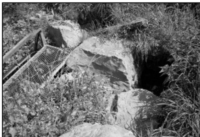
Canalisation (avec grille) en bordure de chemin à l'emplacement du chantoir renseigné sur le plan Pop (1850) - Pt 3
