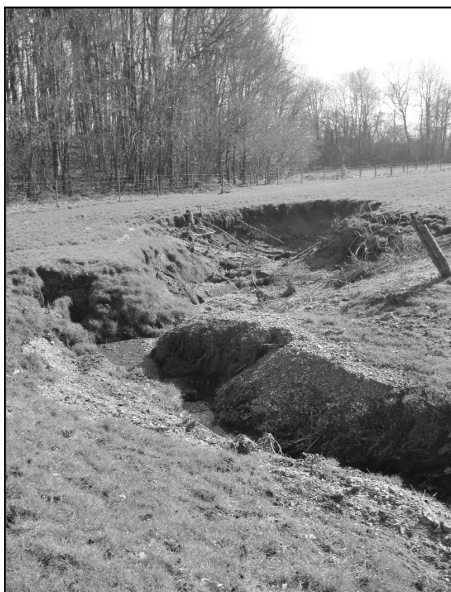
Ravinement et approfondissement de la dépression du chantoir de la Noire Fontaine (Photo CWEPSS - mars 2011).
