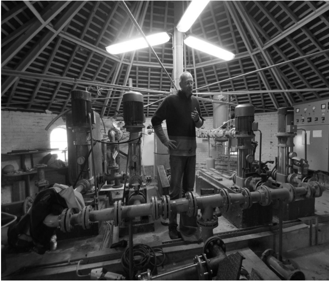
Système de pompe et de chloration du captage du Cerf exploitant une émergence karstique dans le centre de Cerfontaine
