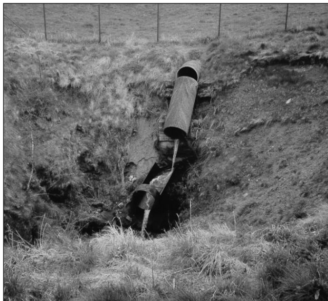
Des rejets directs d'eaux usées dans le sous-sol restent une pratique trop fréquente. L'inclusion de tel bassin karstiques parmi les zones prioritaires et sensibles obligerait à l'épuration avant rejet dans le milieu ambiant particulièrement vulnérable.
