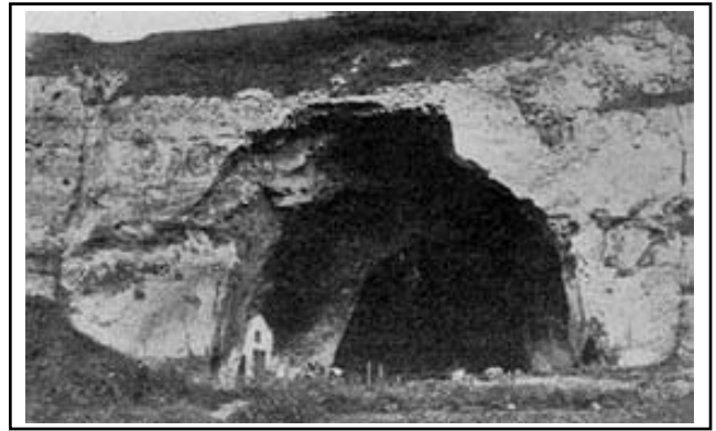
Un des nombreux porches donnant accès aux réseaux souterrains de la Montagne Saint Pierre creusés pour l'exploitation de la craie phosphatée
