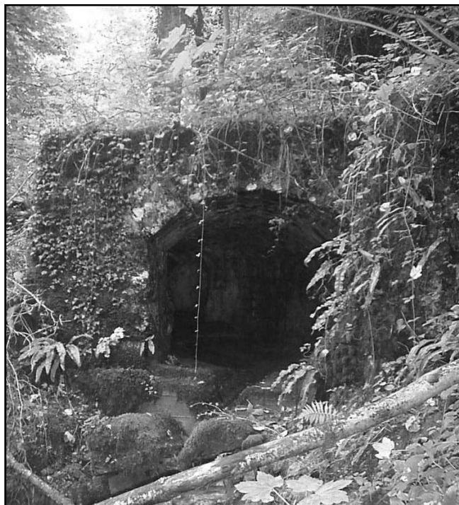
Galerie de la Source de Freyr, creusée en pleine roche et permettant de récolter les eaux qui alimentent les jardins du château
