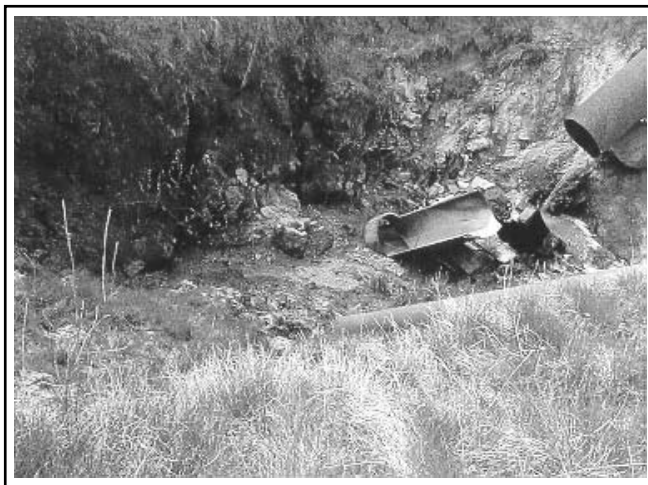
Doline-égout des Auges (Province de Namur, carte 47/7 - vallon de Lesve), cette dépression de 25m de diamètre pour 5m de profondeur présente des affleurements calcaires en son fond; et reçoit les eaux usées d'un égout. Photo juin 2002.
