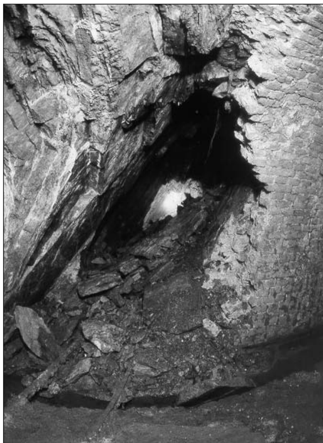
Veine de charbon et mur de soutènement dans la galerie principale à hauteur d'une zone connaissant quelques effondrements. Photo Vincent Vincke.
