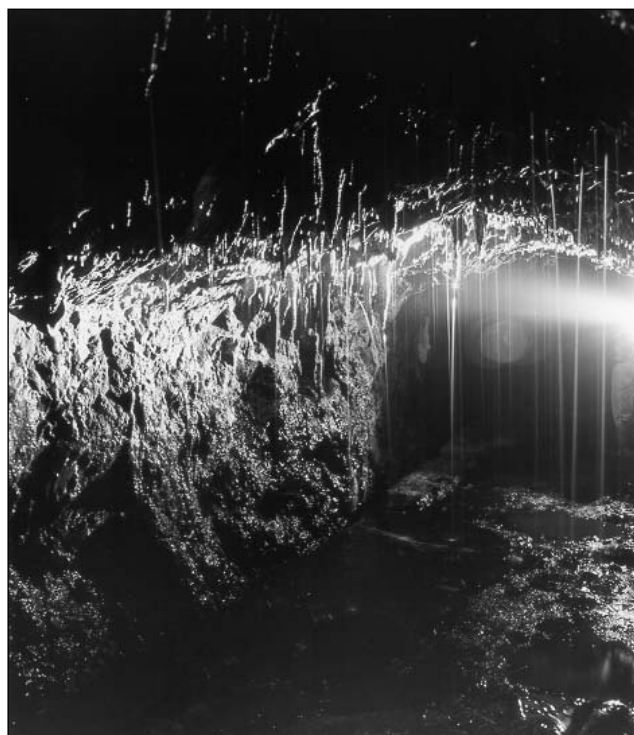
Zone basse de la galerie principale présentant une importante percolation d'eau et la formation de fistuleuses aux pigmentations variées liées aux oxydes dissous par les eaux de percolation. Photo Vincent Vincke.
