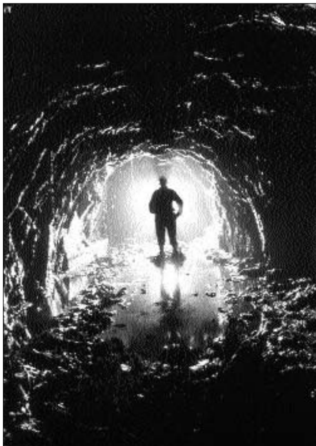
Galerie latérale faisant partie du système souterrain de la galerie de la Chartreuse (Liege) - photo Vincent Vincke. Cette cavité artificielle (galerie d'exhaure et d'extraction d'un charbonnage) a reçu le statut officiel de CSIS en janvier 2002
